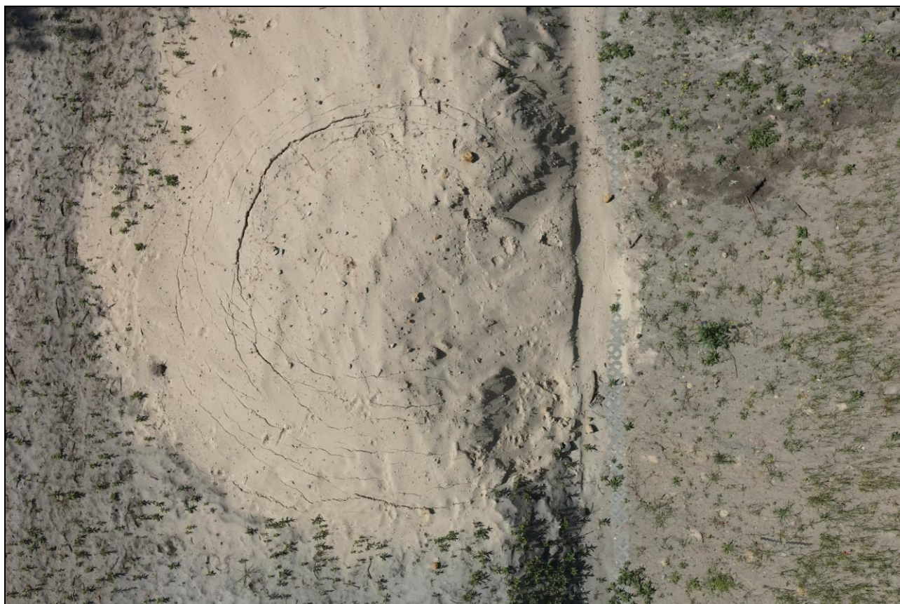
Rys. 10. Cylindryczne spękania w obrębie zasypanego zapadliska powstałego w lutym 2023 roku
