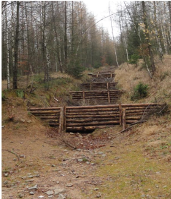
Zapora antyerozyjna w nadl. Śnieżka (Fot. E. Hałdaś)
