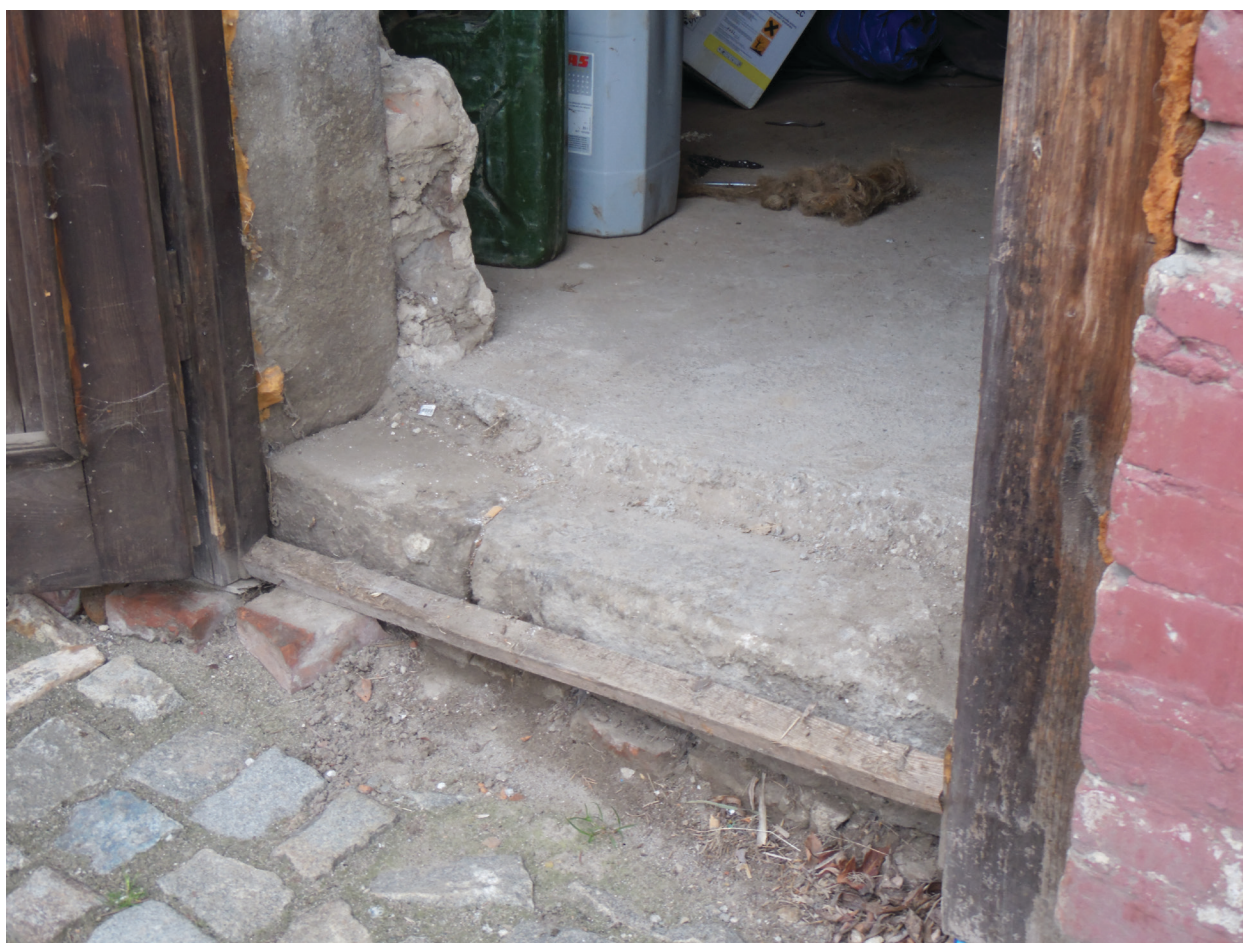
Progi w przejściach stanowią zagrożenie wypadkowe podczas wykonywania codziennych czynności gospodarskich, a upadki to nadal połowa wszystkich zdarzeń wypadkowych w rolnictwie
