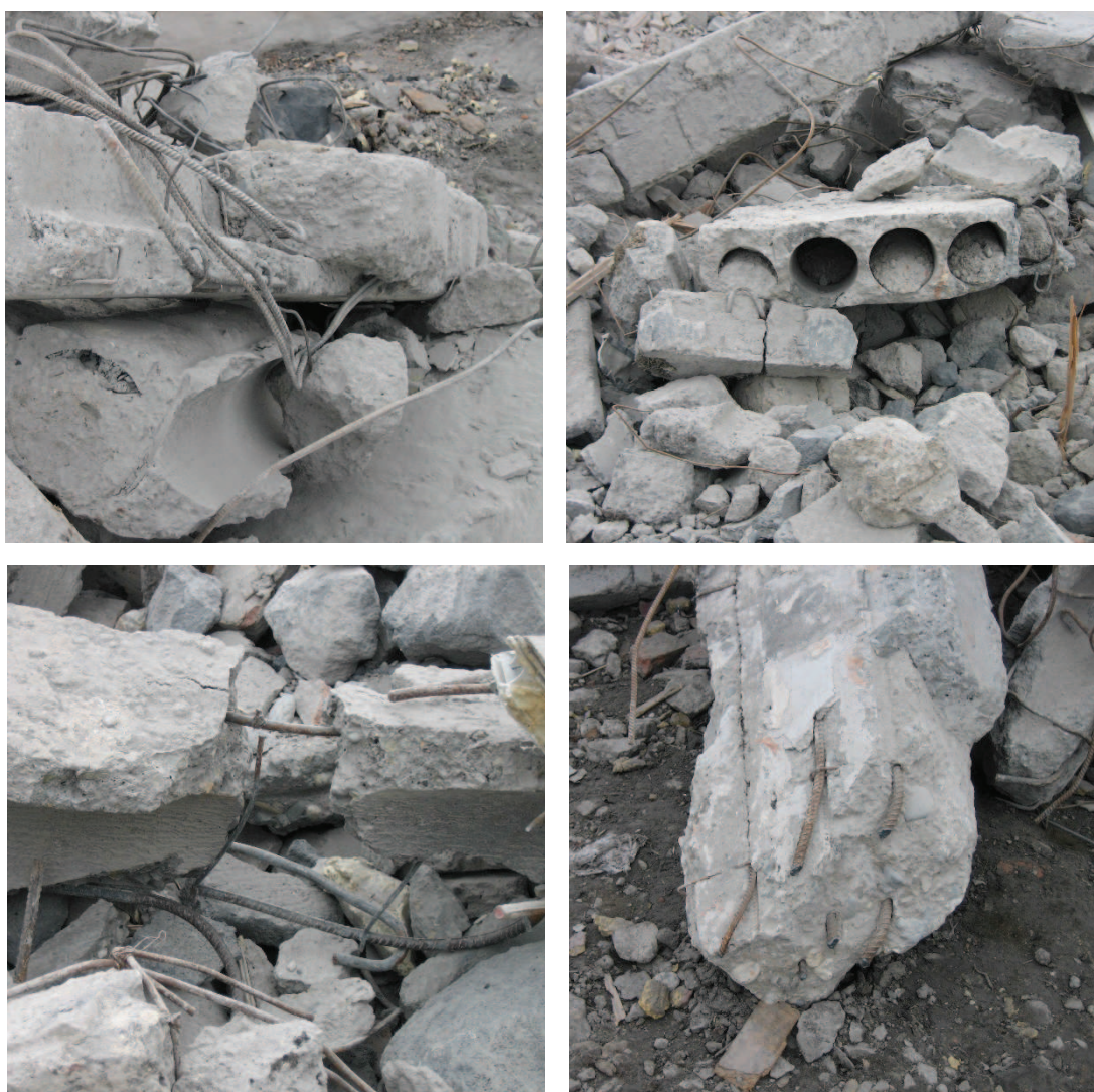
Rys. 10. Widok elementów prefabrykowanych i ich zbrojenia podczas rozbiórki budynku wielkopłyтового /źródło: J. Szulc/
