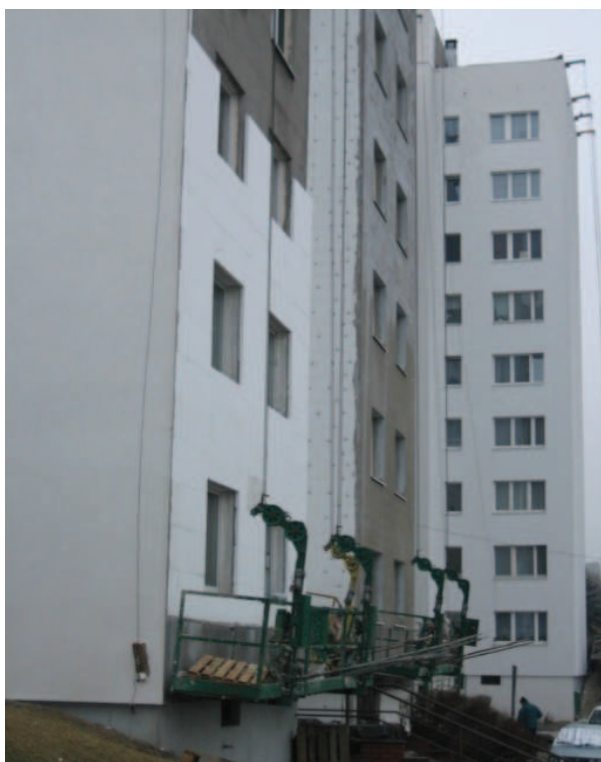
Rys. 15. Przykład termomodernizacji typowego budynku wielkopłytowego (prace w toku) /źródło: J. Szulc/
