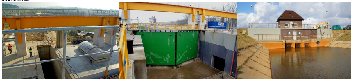
Elektrownia wodna. Wrota górne na śluzie, w oddali widok na sterówkę. Przepompownia. Autor: RZGW Wrocław
